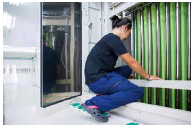
全長16メートル、高さ5メートルの光触媒定着装置
